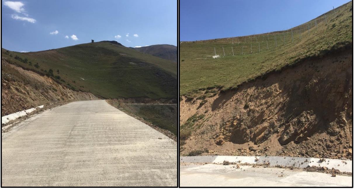
Şekil 6-7: Limni Gölü ile Zigana Kayak Merkezi Arasındaki Beton Yol ve Çığ Setleri
